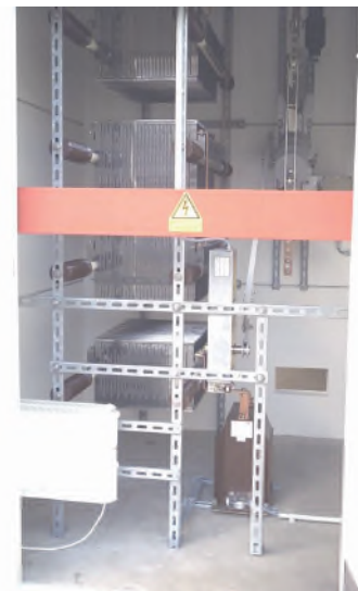
2 NOSPE-Widerstände in einer Betonstation 30kV, 2000A, 10s mit motorbetriebenen Lasttrennschaltern zur Sternpunktterdung an zwei Transformatoren 2 earthing resistors in a substation 30kV, 2000A, 10s with load break switches with motor drives for 2 transformers
